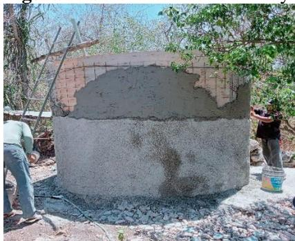
**Figura 8.** Colocación del revestimiento de cemento al tanque
