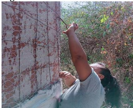
**Figura 7.** Colocación de la malla y Revestimiento al tanque
