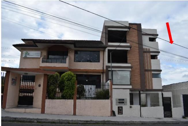
Se evidencia nula separación entre estructuras adyacentes, estructura lado izquierda 12 años de existencia, estructura lado derecho 1 año de existencia; edades aproximadas.
