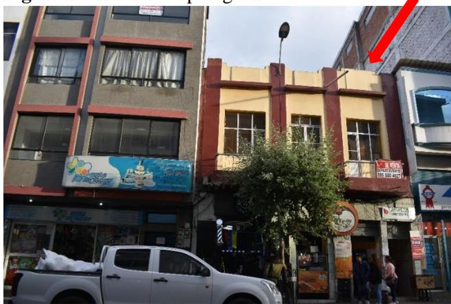
Se evidencia la separación entre las estructuras, estructura lado izquierda 35 años de existencia, estructura lado derecho 40 años de existencia; edades aproximadas.
