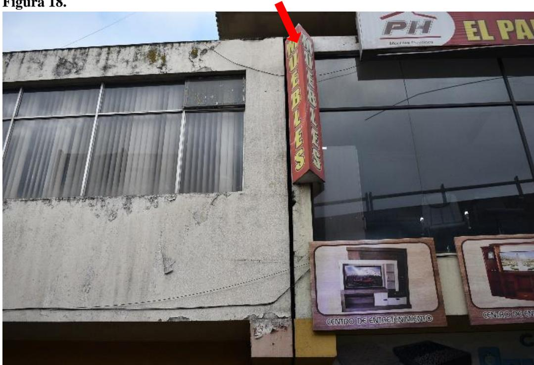
Edificios tipología D, se evidencia la separación entre las estructuras adyacentes, estructura lado izquierda 40 años de existencia, estructura lado derecho 35 años de existencia; edades aproximadas.
