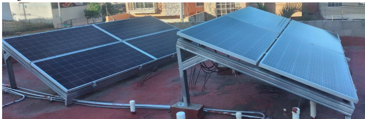
Figura 2. Instalación de paneles solares fijos utilizada para la recopilación de datos de generación de energía fotovoltaica
