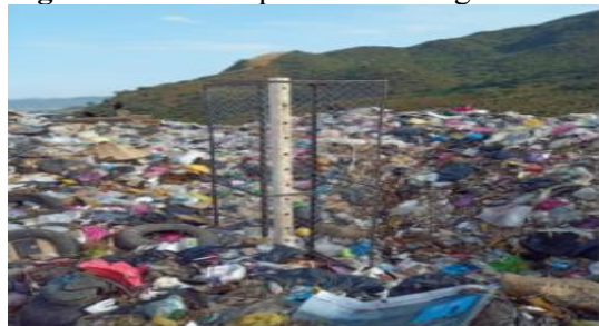
Figura 6. Tubo respiración de biogases en celda #1 en Simar Sur Sureste.
