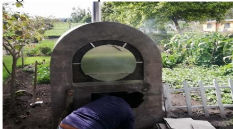
Figura 14. Comprobación de una correcta construcción
