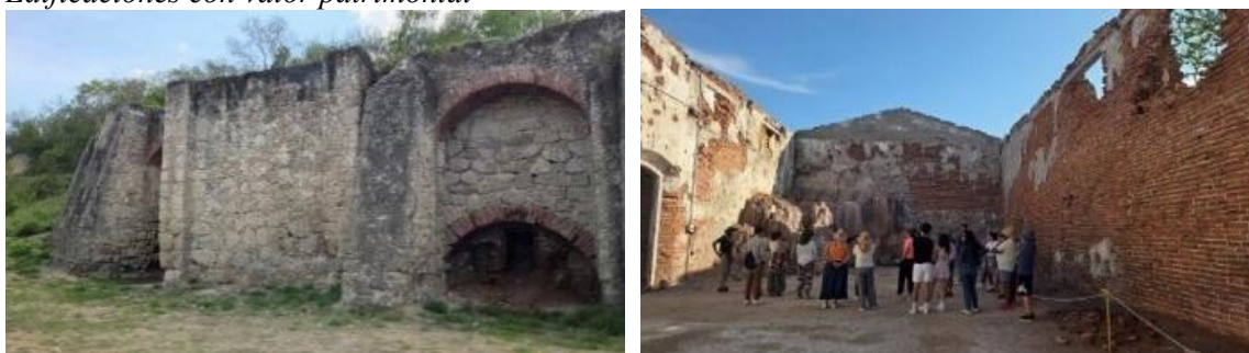
Figura 4 Edificaciones con valor patrimonial
