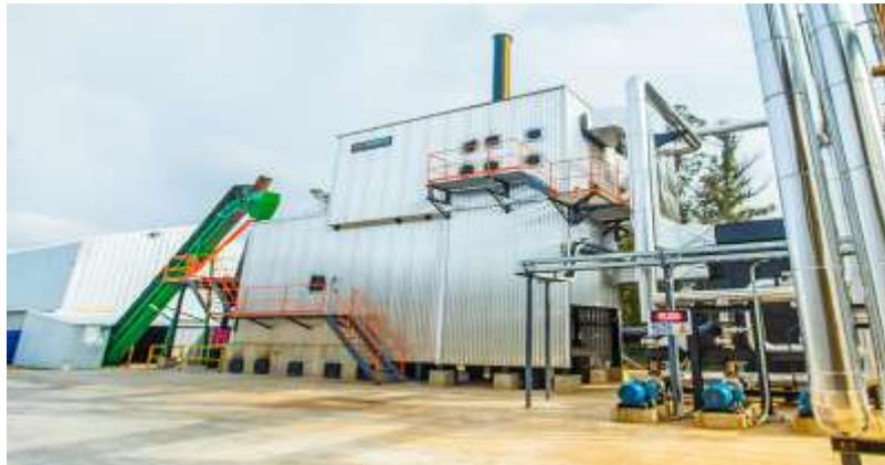
Figura 14: Caldera para biomasa difícil de combustionar por su alto contenido de humedad e impurezas.
