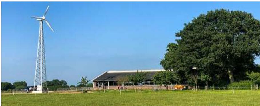
Figura 11: El aerogenerador E200 suministra el 80% de la energía demandada por la granja.
