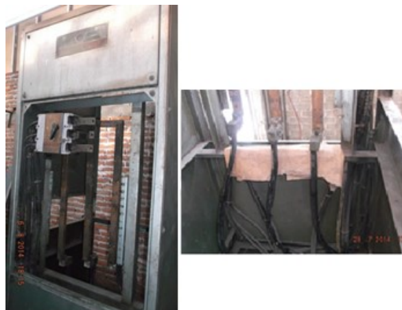
Figura 3. Tablero de distribución en la subestación de materiales, de la marca Federal Pacific.
