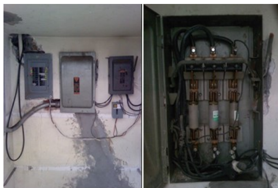
Figura 3. Tablero de distribución en la subestación de materiales, de la marca Federal Pacific.
