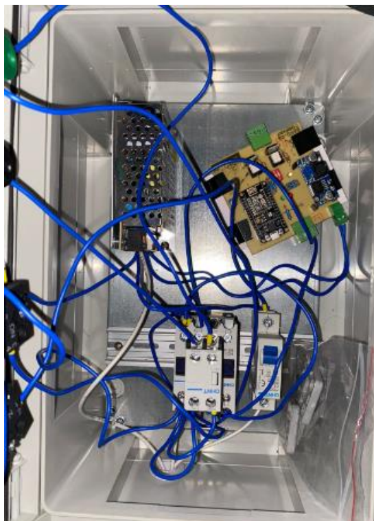
Imagen 7 Colocación previa al ensamblado de los componentes
