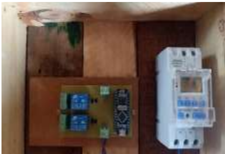
Figura 4. Montaje del prototipo en la caja de madera
