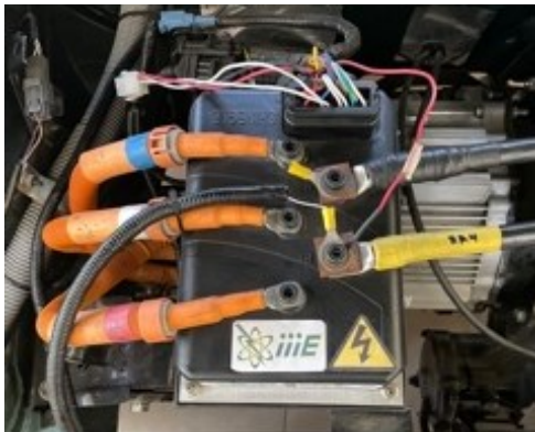
Controlador del motor eléctrico
