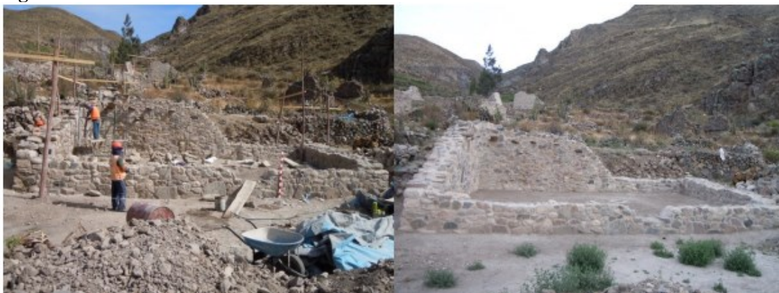
Al lado izquierdo, vista del recinto 07 fotografiado de este a oeste después de la intervención, se observa el recinto acabado. Al lado derecho, vista del recinto 08 fotografiado de este a oeste después de la intervención, se observa el recinto acabado.
