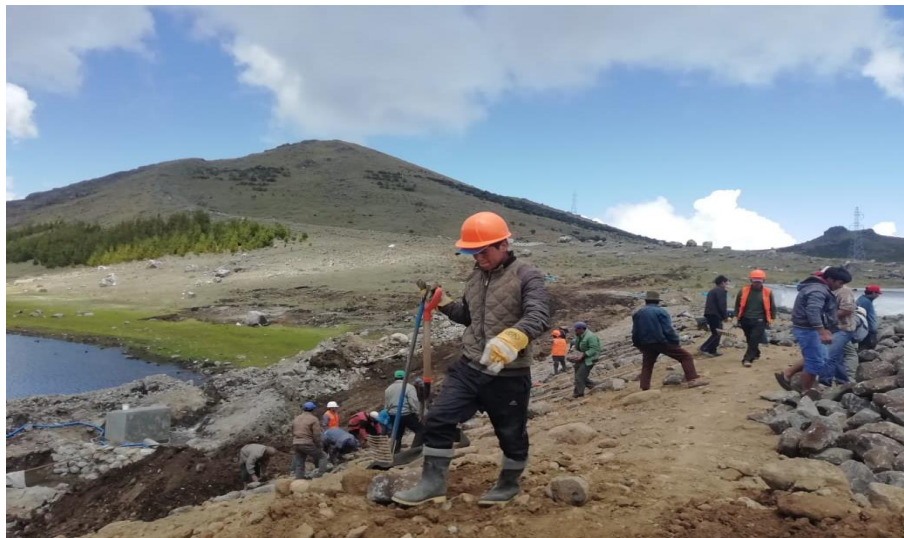
Figura 5. Comuneros de Tintay apoyando en el represamiento de la laguna mayor de Pichqagocha. Fuente: Comunidad de Tintay (Abril de 2020 )
